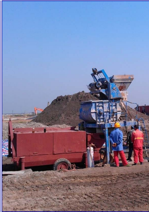
图 2 土-膨润土地面搅拌
