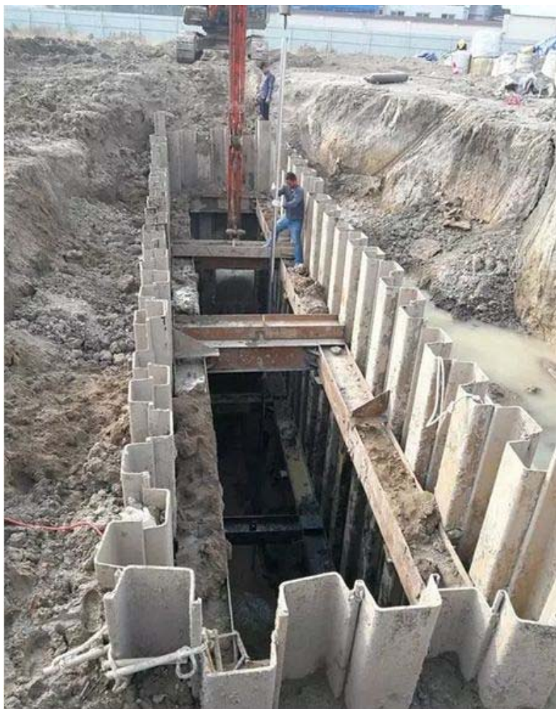
图 9 渗透反应墙钢板支护
