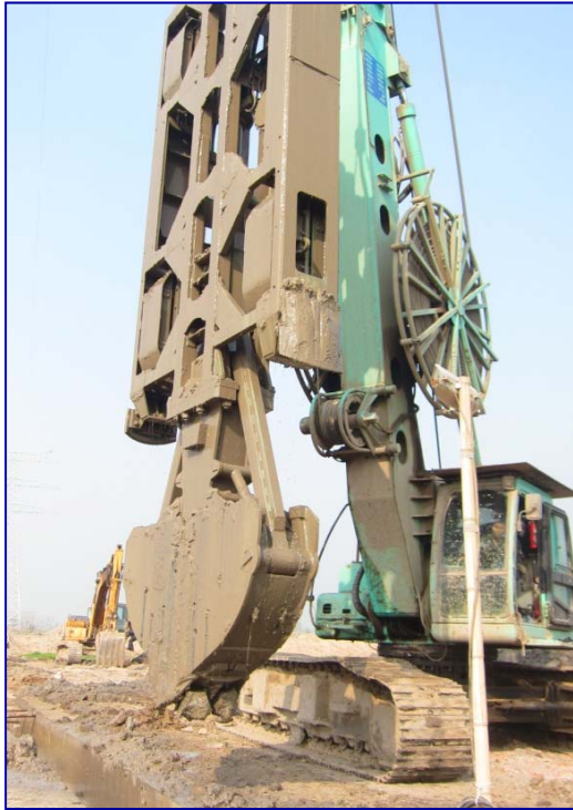
图 1 液压抓斗机械开槽
