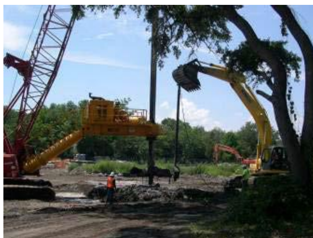
图 7-4 特制的探测取样设备（取样评估混合是否均匀和边界是否重合）
