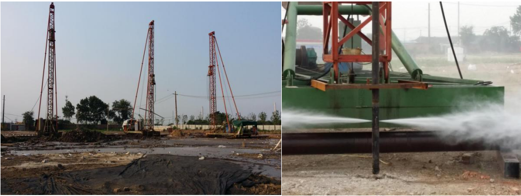
图 8 污染土壤/地下水原位注入实施照片
